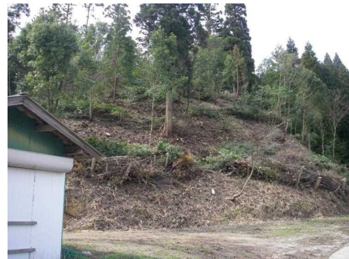
里山防災整備施工後
