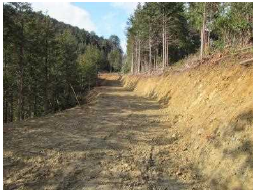
間伐材搬出道(大津市)
