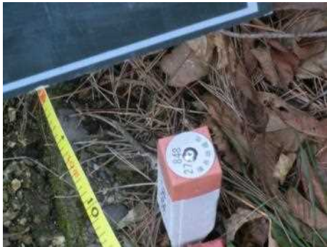
境界杭の設置
